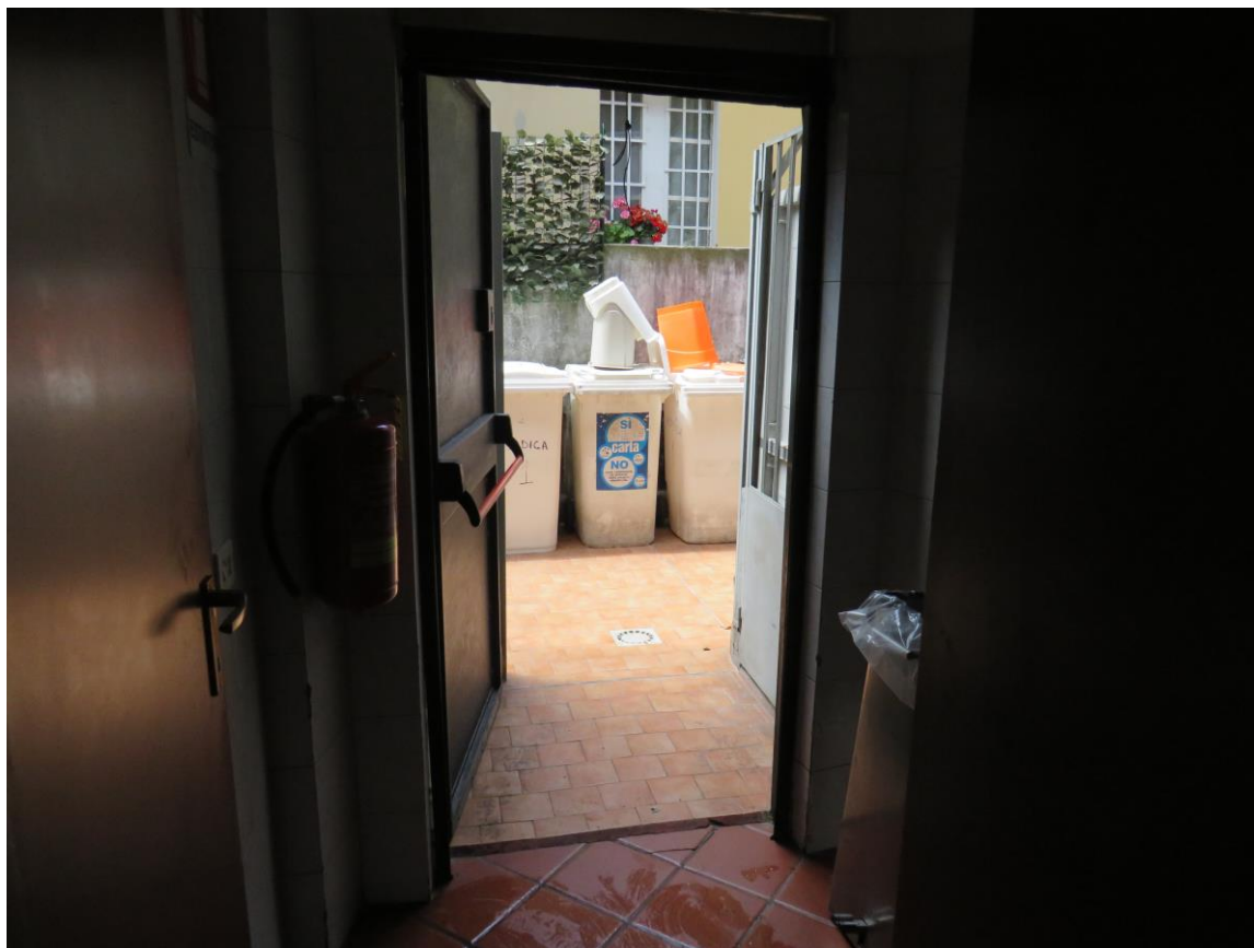
DISIMPEGNO SU CORRIDOIO POSTERIORE
